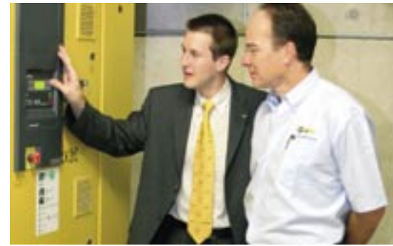
Bild 4: Die interne Steuerung „Sigma Control“ gibt Auskunft über Betriebs- und Wartungsdaten der Druckluft-Kompaktanlage
