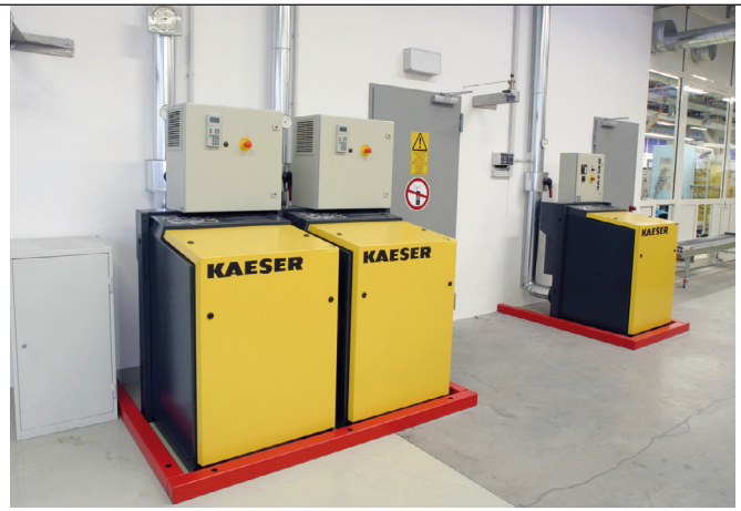
Die Drehkolbengebläse der Tampondruckerei: energieeffizient und geräuscharm
