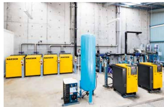
*Vier Drehkolbengebläse der COMPACT-Serie von KAESER liefern Prozessluft für den Membranbioreaktor.*
