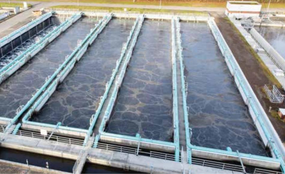
In den Belebungsbecken dient Druckluft zur Sauerstoffversorgung der hier tätigen Mikroorganismen.
